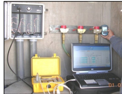
Figura 8. Equipos de medición de celdas de asentamiento
