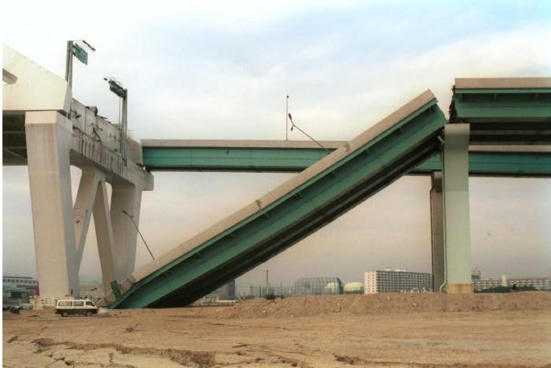
**COLAPSO DE UN TRAMO DEL PUENTE NISHIHOMIYA, DEBIDO AL DESPLAZAMIENTO LATERAL DE LOS MUROS DE APOYO DURANTE EL SISMO DE KOBE, 1995**
