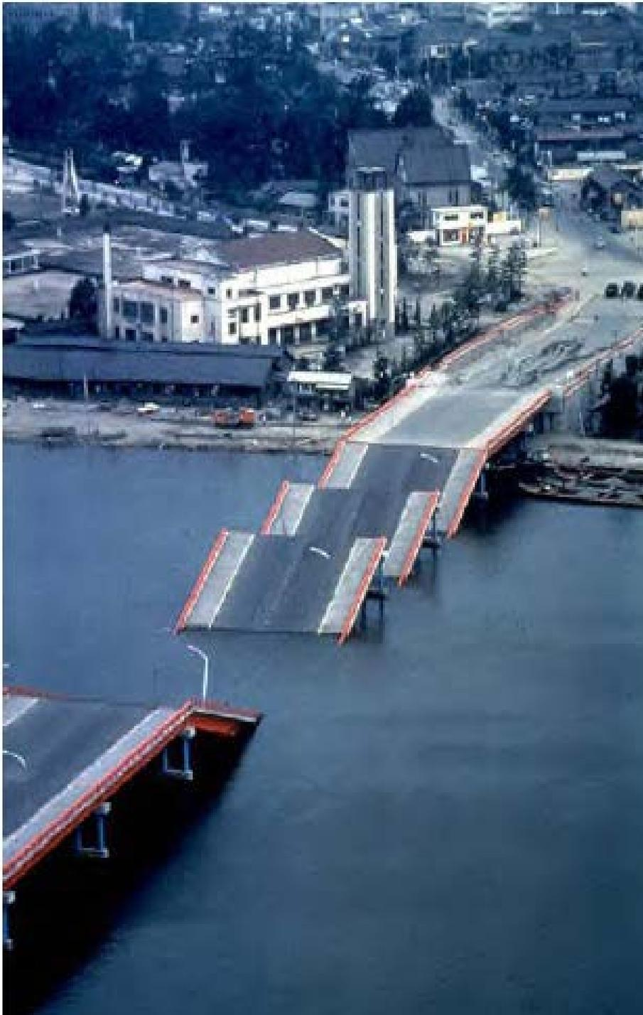
**COLAPSO DEL PUENTE SHOWA DURANTE EL SISMO DE NIIGATA, 1964. APARENTEMENTE LA LICUACIÓN DE SUELOS OCASIONÓ EL MOVIMIENTO LATERAL DE LA BASE DE LOS PILARES LO QUE ORIGINÓ LA PÉRDIDA DE CARGA Y EL COLAPSO**
