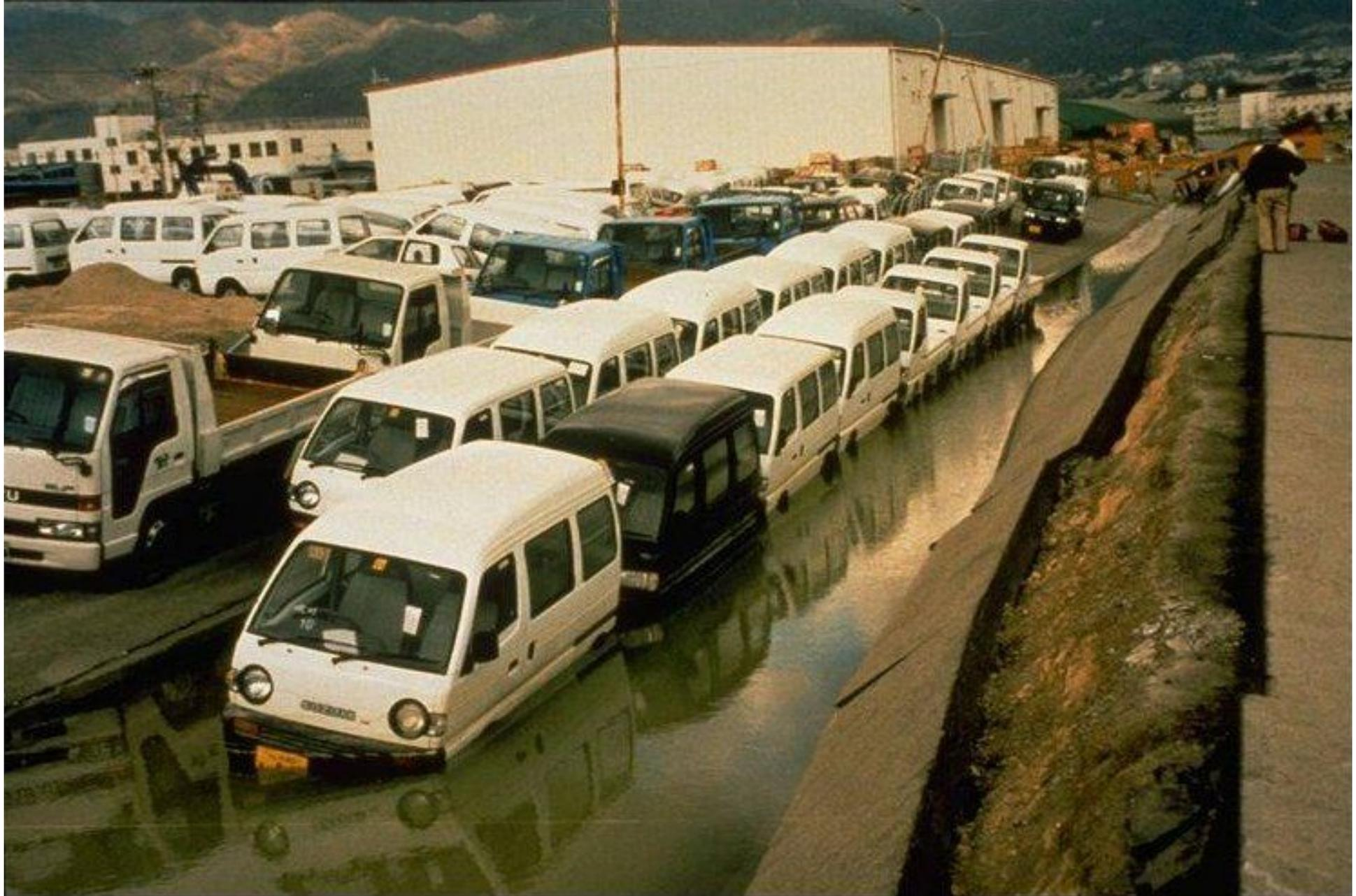
**DESPLAZAMIENTO LATERAL DEBIDO A LICUACIÓN DE SUELOS. OCACIONÓ EL HUNDIMIENTO DE 1.2 – 2.00 METROS DE LA SUPERFICIE DEL PAVIMENTO Y FLUJO LOCAL. SISMO DE KOBE, 1995**
