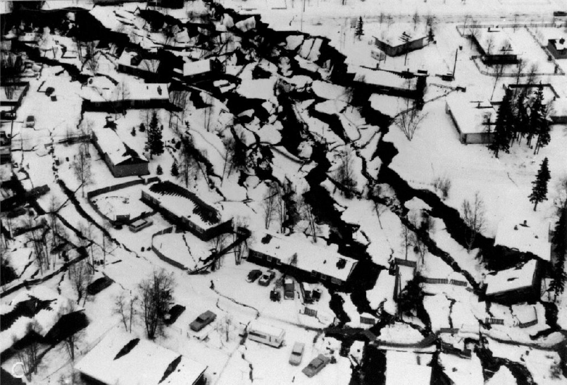
**DESLIZAMIENTO EN TURNAGAIN HEIGHTS EN ANCHORAGE, DEBIDO A LICUACIÓN DE SUELOS OCACIONADA POR EL SISMO DE ALASKA DE 1964**
