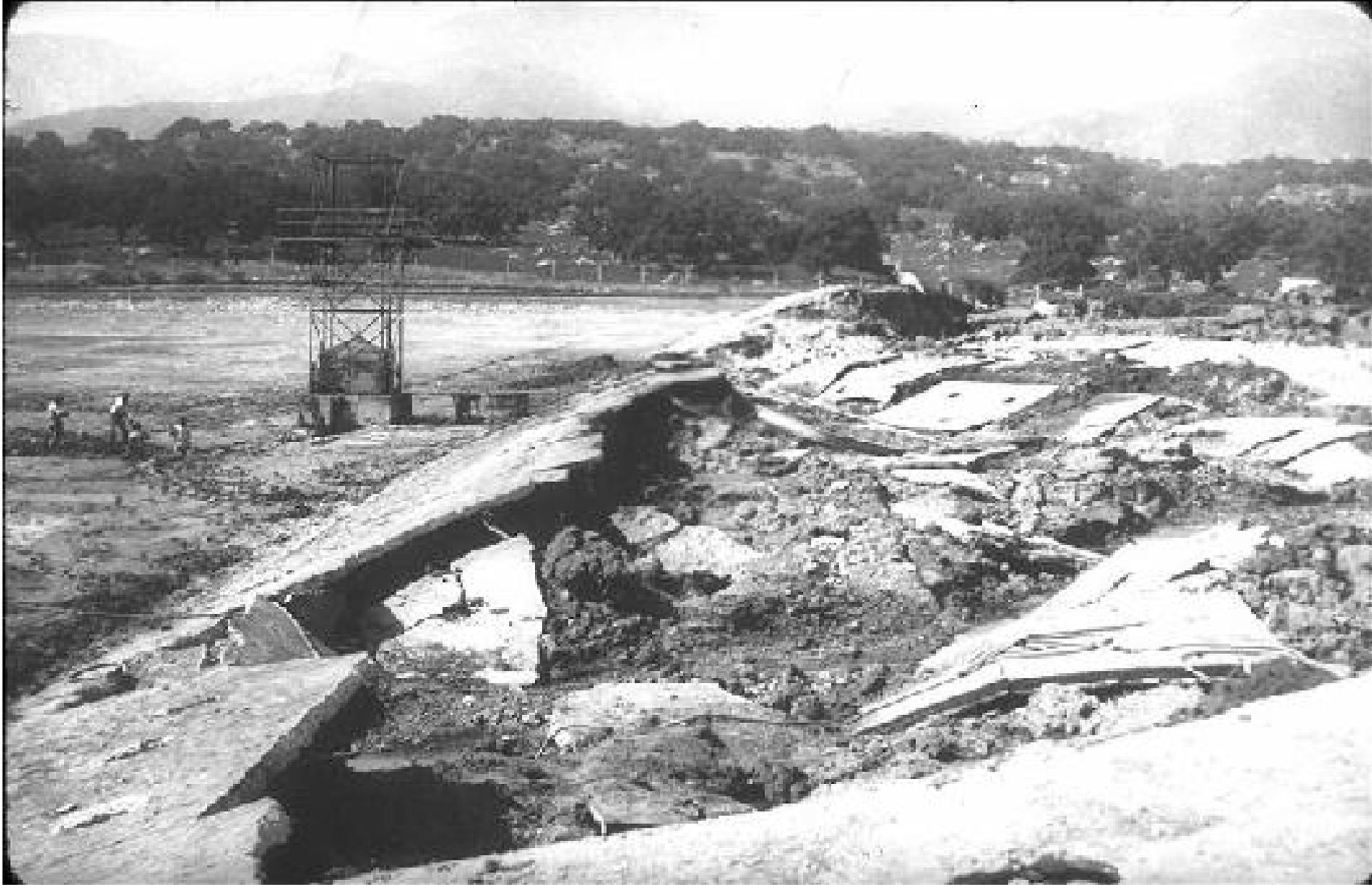
**LA PRESA SHEFFIELD SUFRIÓ UNA FALLA POR FLUJO PROVOCADO POR EL TERREMOTO DE SANTA BÁRBARA EN 1925. UNA SECCIÓN DE 90 METROS (DE LOS 220 METROS DE LONGITUD DE LA PRESA) SE DESPLAZÓ MÁS DE 30 METROS. LA PRESA CONSISTÍA PRINCIPALMENTE DE ARENAS LIMOSAS Y LIMOS ARENOSOS COMPACTADOS SOBRE EL RELLENO**
