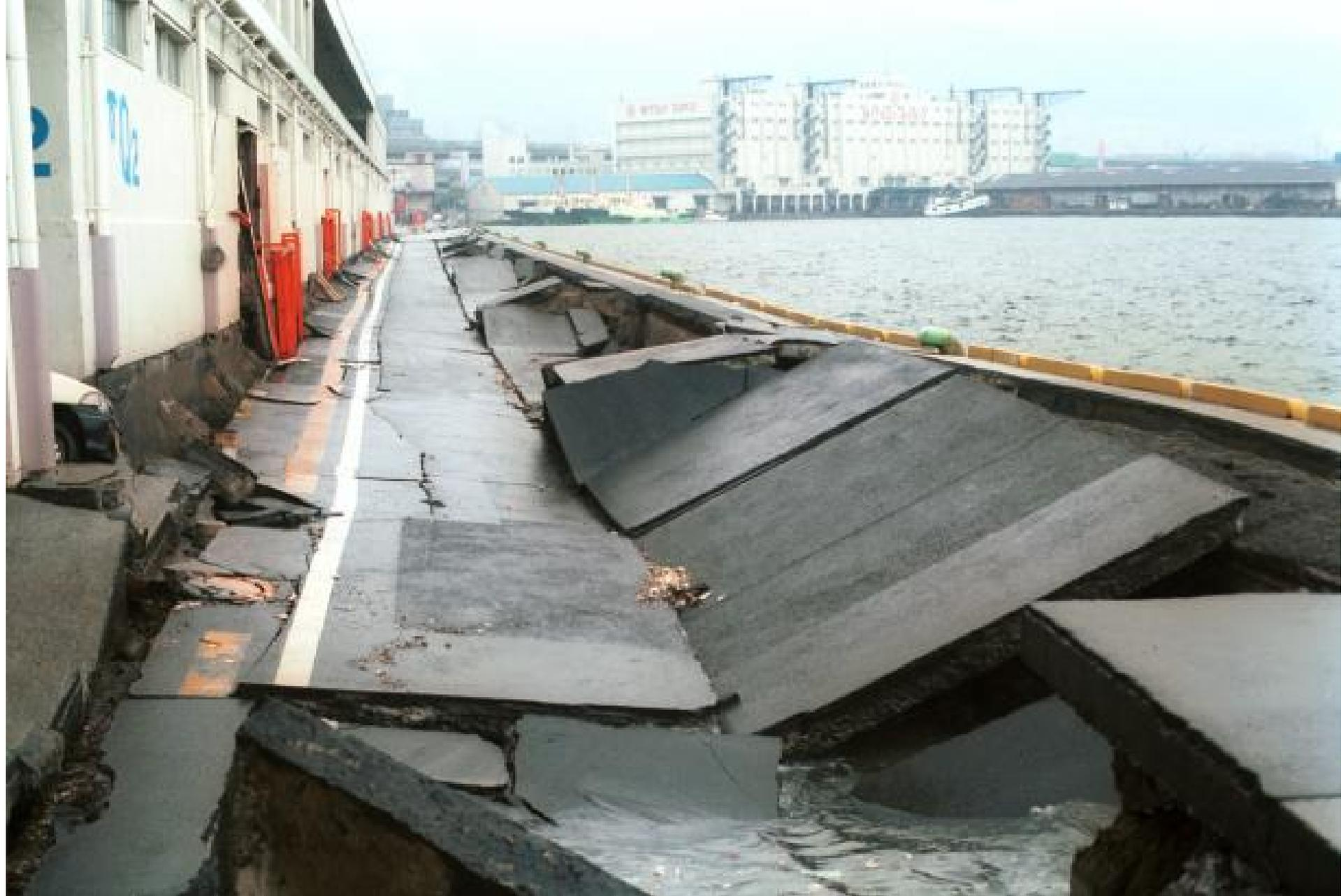
**DESPLAZAMIENTO LATERAL DEL MURO DE RETENCIÓN DEBIDO A LICUACIÓN DE SUELOS DURANTE EL SISMO DE KOBE DE 1995. DEBIDO A QUE EL MURO DE RETENCIÓN FUE MOVIDO HACIA AFUERA, LA SUPERFICIE DEL TERRENO SE HUNDIÓ**
