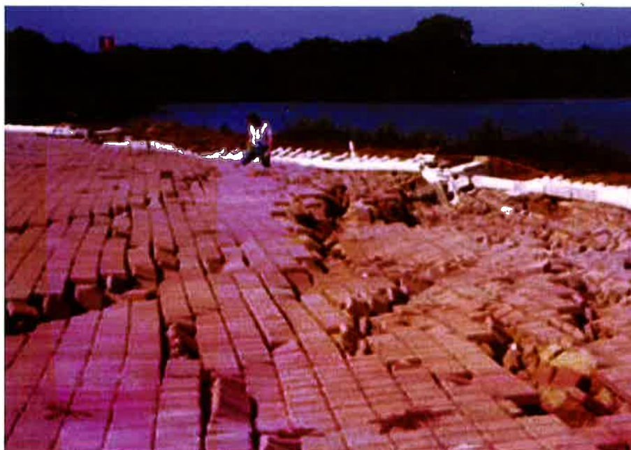
Figura 1.16. Desplazamientos laterales inducidos por licuación, Manzanillo, Colima 2003.
