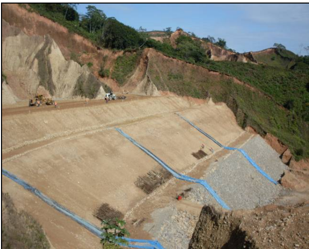
Figura 5. Conformación de terraplenes
