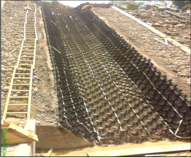
Figura 7. Instalación del Geoweb en las rápidas
