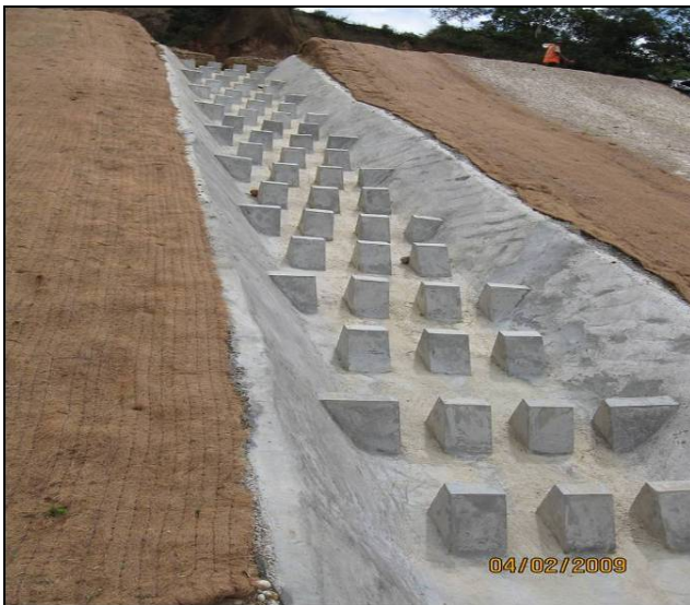
Figura 9. Geoweb con concreto mas disipadores
