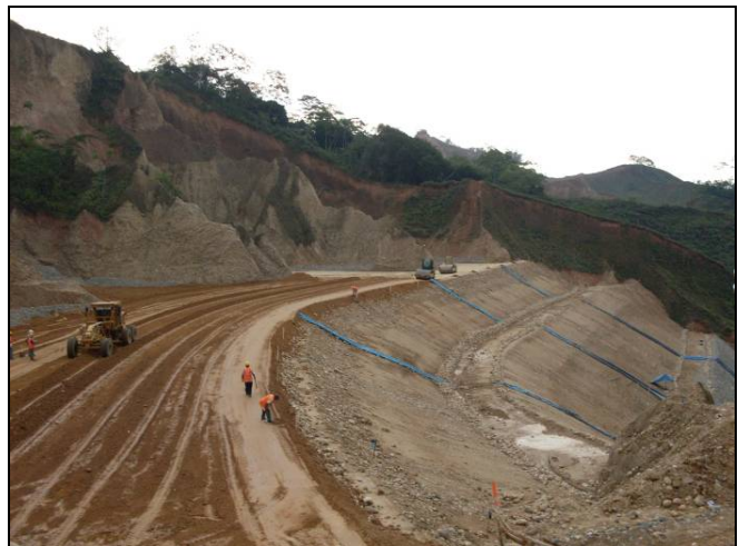
Figura 6. Acondicionamiento de bajantes para rápidas.
