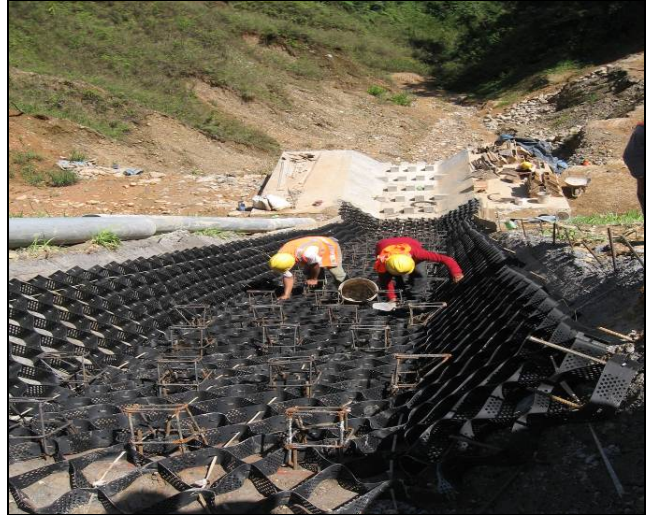
Figura 8. Colocación de los dados disipadores
