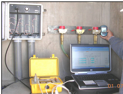
Figura 7. Equipos de medición de celdas de asentamiento
