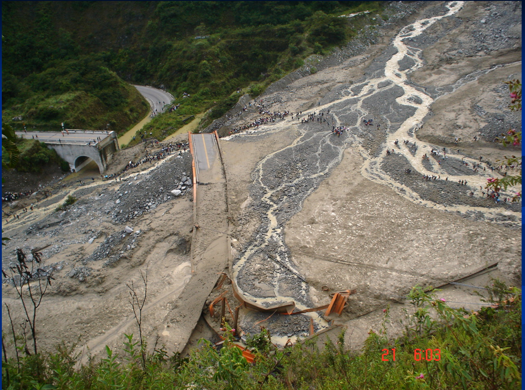
PUENTE YANANGO COLAPSADO
